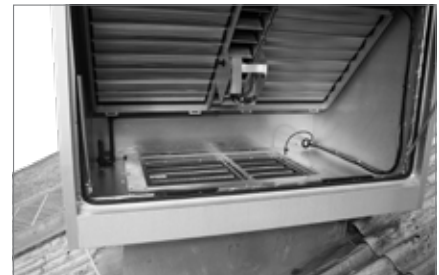
Slika 43: Filter za odvedeni zrak
