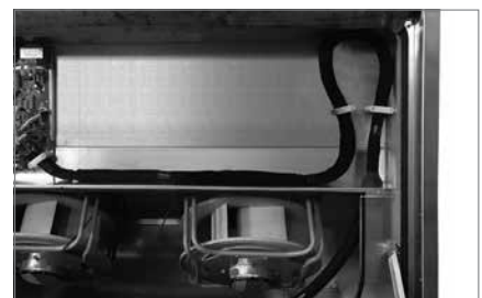
Slika 38: Učvršćivanje svežnja kabela u krovnoj jedinici
