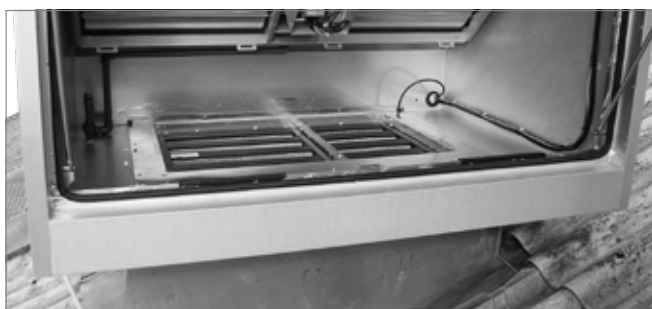
Slika 28: Filter odsisanog zraka postavljen u jedinicu
